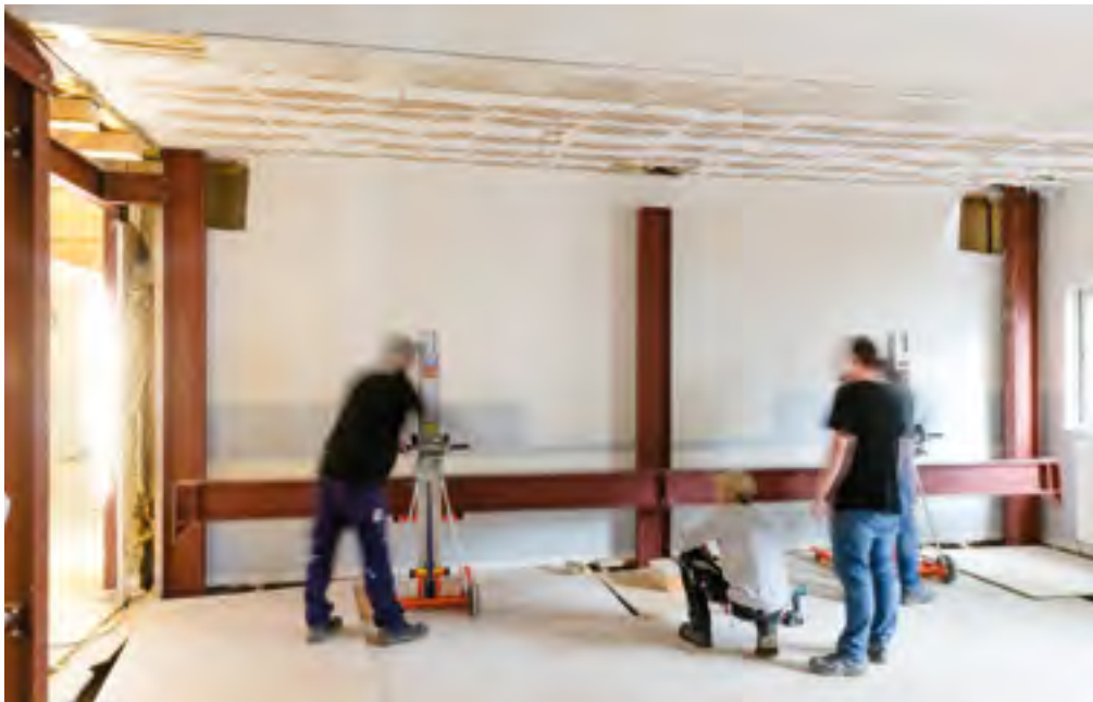
Montage des deux moitiés de cadres de part et d'autre du mur existant.
