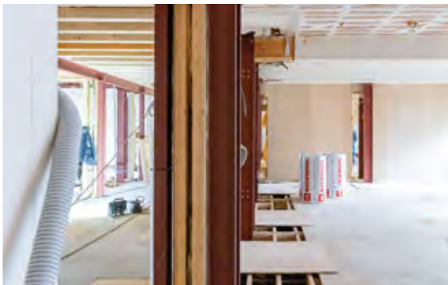
Création des ouvertures dans les murs en ossature bois pour pouvoir réaliser une liaison entre les cadres salle de classe et ceux du couloir.
