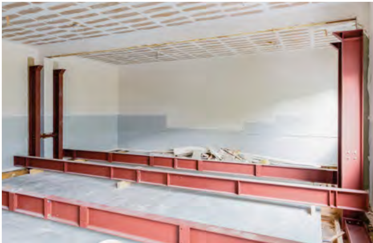
Création d'ouvertures dans le plancher du 1 er étage permettant l'assemblage des quatre poteaux du cadre à double hauteur et le montage du cadre à travers les planchers existants.
